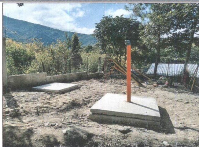
Foto 2: Fosas sépticas para sanitarios mejoradas.
