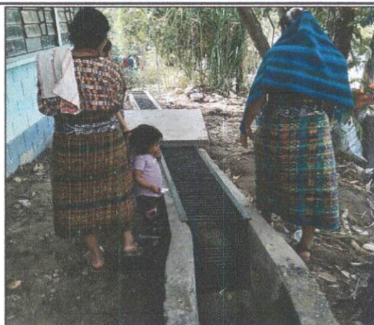
Foto 4: Cunetas y su alcantarillado respectivo mejorado.
