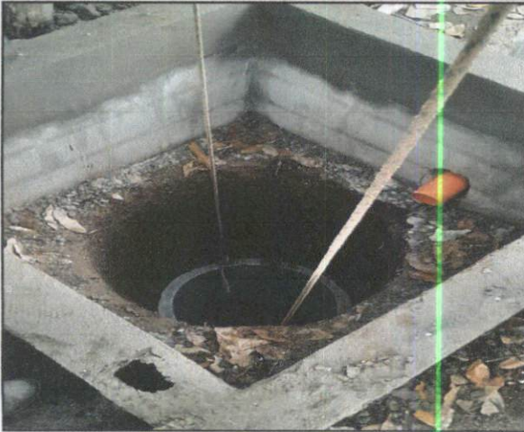
Foto1: Colocación de tubos de concreto en fosa séptica.
