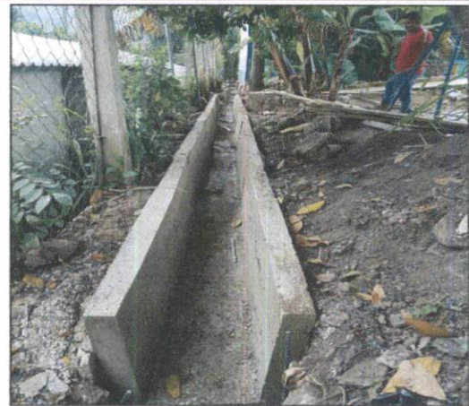
Foto 4: Mejoramiento de cunetas.
