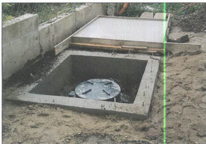
Foto 1: Fosa séptica de 1100 litros Rotoplas colocada.
