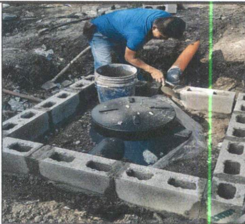
Foto 3: Colocación de fosa séptica 1100 litros Rotoplas y su respectiva base de concreto.
